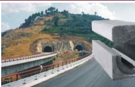
Foto: Túnel em Lamego
