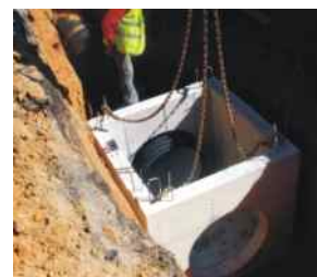
Caixa em instalação - Vila N. Gaia
